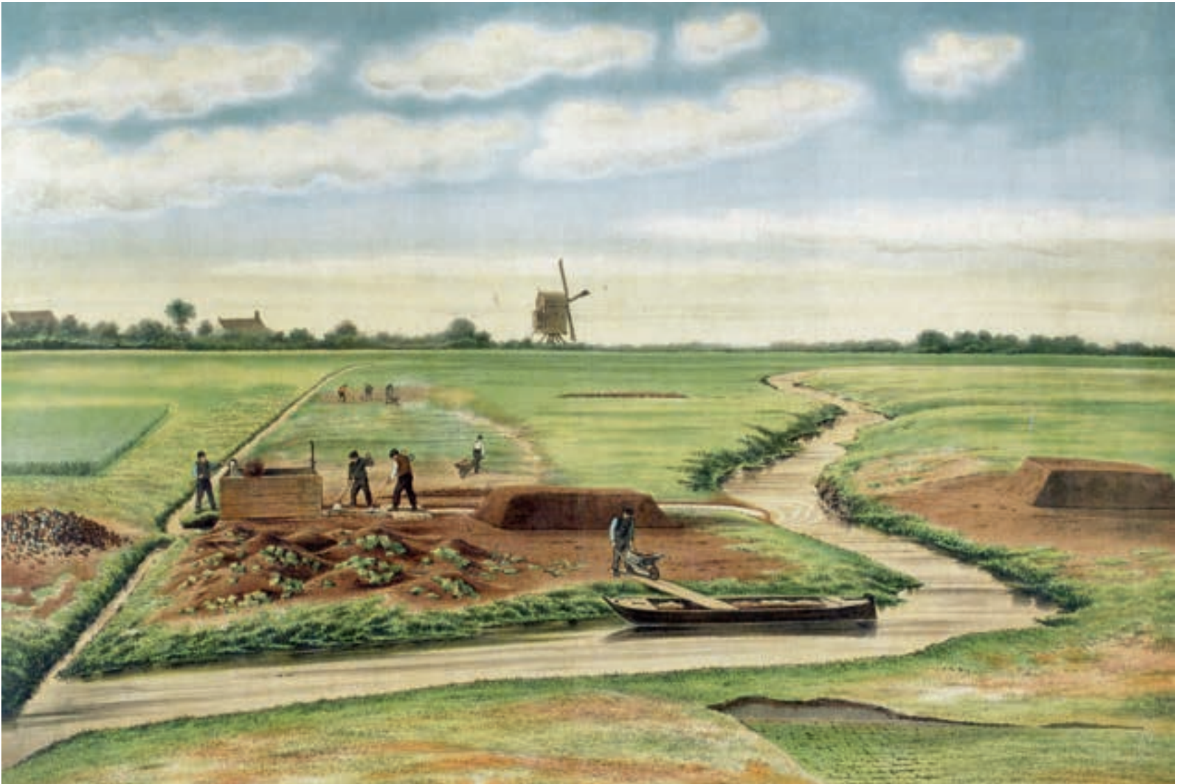
Op deze schoolplaat is te zien hoe de ijzerertswinning in zijn werk ging. De bovenlaag werd verwijderd, waarna de erts werd gewonnen. Dit werd op grote metalen zeven uitgespreid en gewassen om resten grond eraf te wassen. Alleen het bezinksel (het erts) werd gebruikt. (bron: Schoolplaten voor het Aanschouwelijk Onderwijs, ca. 1885)
