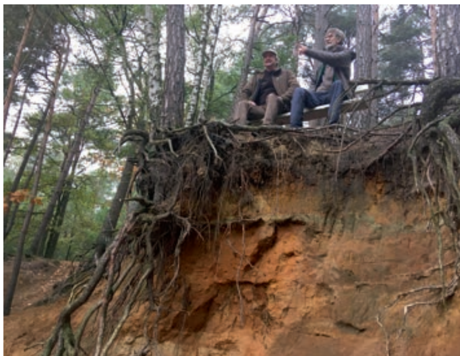
Groeve de Lork: Uitzichtpunten toevoegen en zichtbaar maken.
