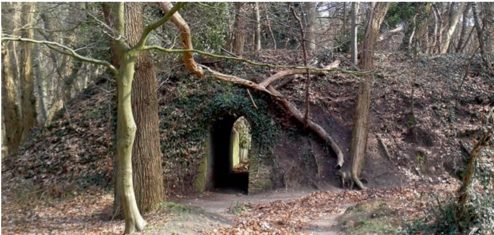
Eén van de bunkers van de voormalige springstoffenfabriek te Herentals. (bron: IOED Land van Nete en Aa)
